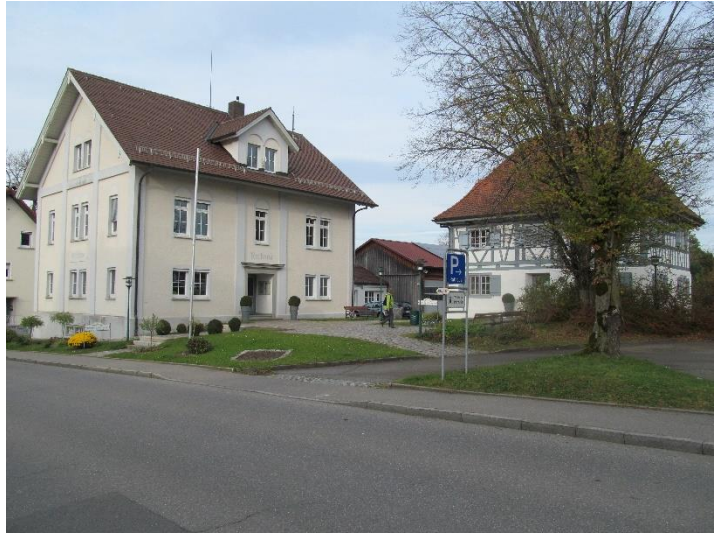
Blick von Süden auf das Rathaus und die "Wolfegg Information" (Rötenbacher Straße 11 und 13)
