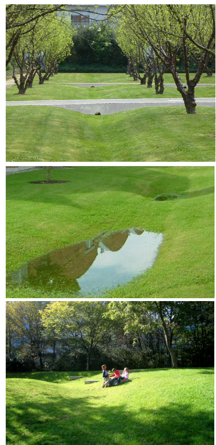
Gartenbereich mit Retentionsmulden Bevor das Niederschlagswasser über den Regenwasserkanal abgeleitet wird, wird es vor Ort zurückgehalten. - Rigolen unter den Parkplätzen versorgen auch die Straßenbäume mit Wasservorrat. - flache Wiesenmulden zwischen den Gärten schaffen Rückhaltevolumen und ermöglichen bereits Verdunstung vor Ort, bevor es am Überlaufgully in den Regenwasserkanal abgeleitet werden kann. Diese gestuften Mulden können Zäune ersetzen und spielerische Durchlässigkeit schaffen. Denkbar ist auch dort eine gemeinschaftliche Zone mit leicht zurückgenommenen privaten Gartenbereichen.
