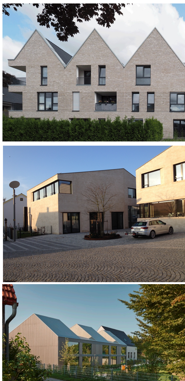
Bewegte Dachlandschaft Die geneigten Satteldächer berücksichtigen die Landschaft mit ihren Aufblicken auf das Gebiet. Der Wechsel zwischen giebel- und traufständiger Anordnung in den Wohnhöfen schafft individuelle Räume. Asymmetrische Dachneigungen oder der Verzicht auf Dachüberstände werden im Sinne einer zeitgemäßen und materialgerechten Gestaltung zugelassen.
