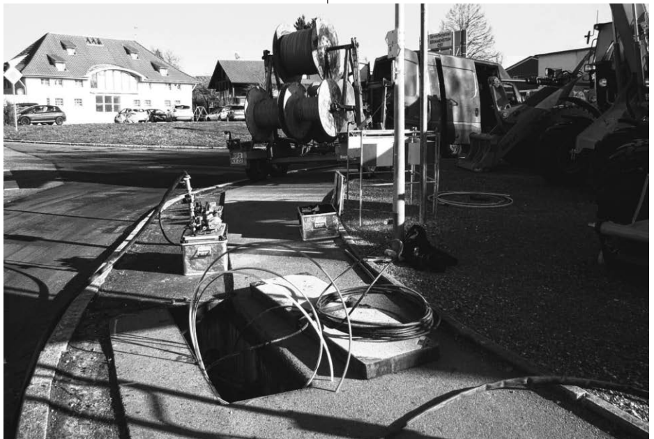
Einblasen der Glasfaserlitzen für das Gewerbegebiet Grimmenstein
