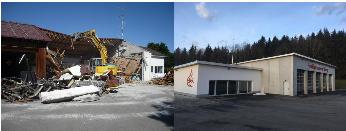
Abbruch Bauhof/Feuerwehrhaus im Sennereiweg | Neubau des Feuerwehrhauses in der Altanner Straße
