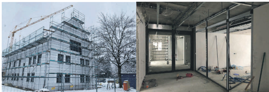
(fertige Außenfassade, Innenausbau im Bereich „Bürgerbüro“)
