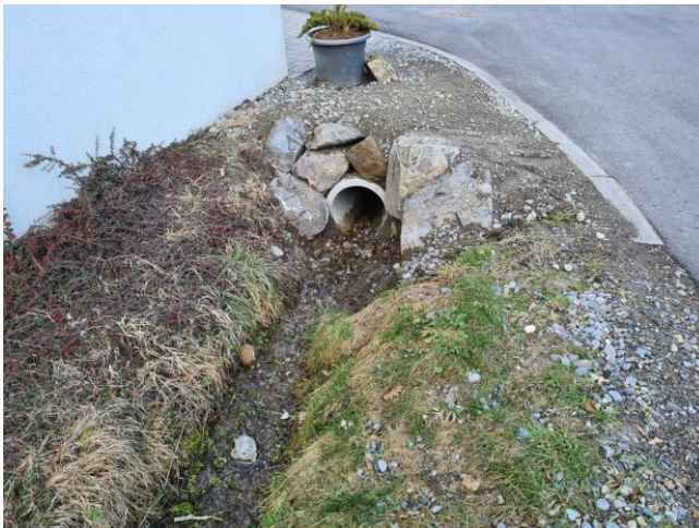
Abbildung 12: Beispielbild eines Durchlasses
